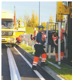
http://www.biseris.lt/projektai/gatves/ pav. Statramsčių kalimas į žemę
