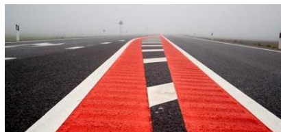
1 pav. Ženklinimas karštu plastikumu
